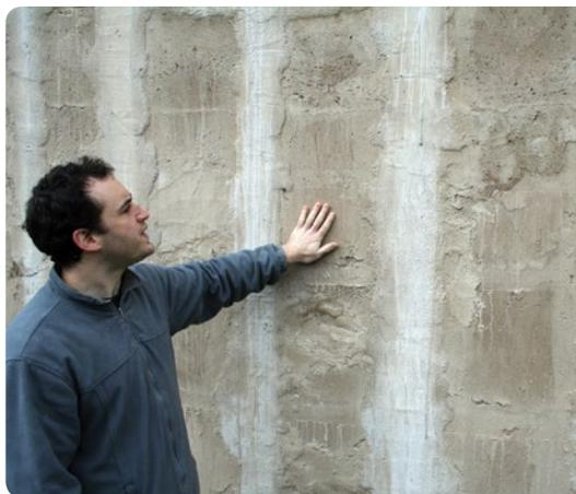
La théorie du GREB recommande de placer un treillis sur l'ensemble d'un mur, préalablement à l'enduisage, explique Christophe, afin de garantir l'uniformité du rendu ; la réparation que j'ai effectuée à l'endroit d'une fuite d'eau dans la cuisine reste donc visible
